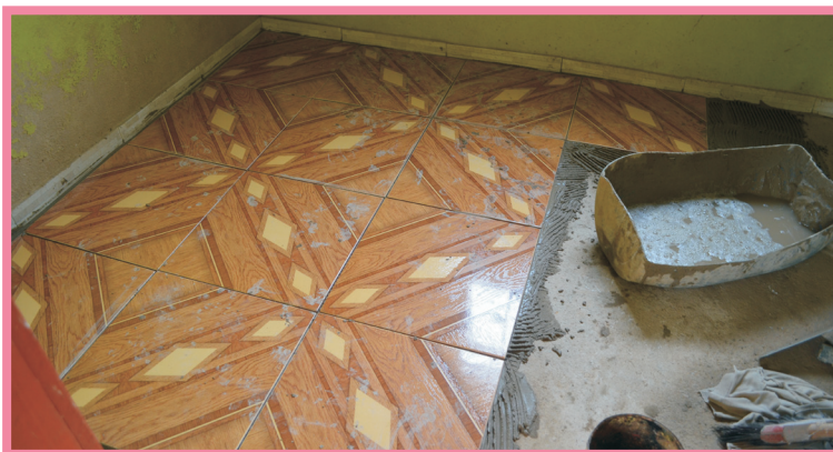
Piso do Centro Comunitário já está em fase final
