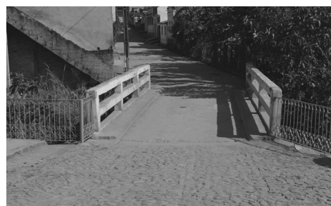
Foram colocadas grades nas laterais da ponte para maior segurança dos transeuntes.
