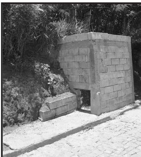
Obra de escoamento da água na rua São José
