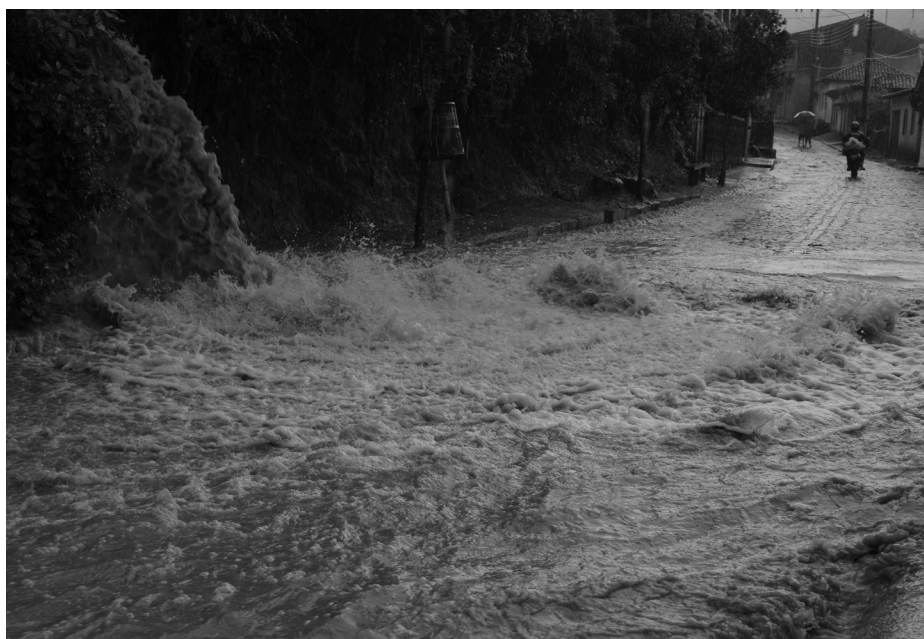
Quando chove a rua fica alagada, o que impossibilita a passagem das pessoas. Além disso, a água que escoam do barranco entra com muita força na casa da frente que fez até um muro para barrá-la.
